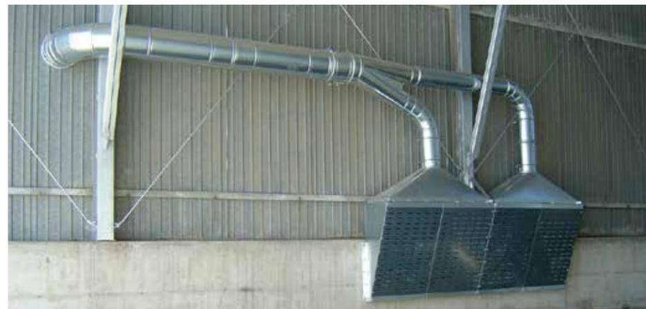
cappe per aspirazione polveri diffuse generate da scarico di materiali di varia natura
