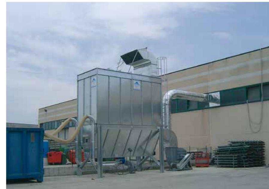
sottostazione filtrante completa di ventilatore e tubazioni di travaso su cassone chiuso
