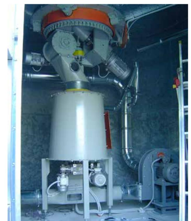
▶ sistema di scarico silo e alimentazione caldaia a cassone chiuso
