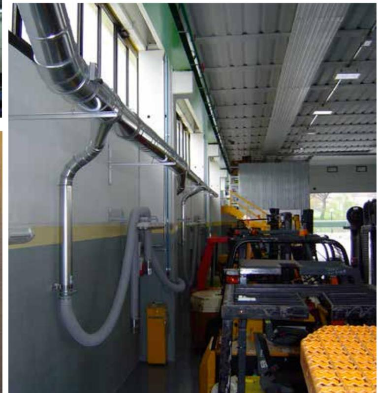
linea di aspirazione per fumi gas di scarico
